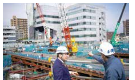
複合施設「あつめき」の工事現場で
