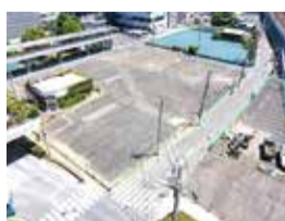
建設工事前（23年7月）
