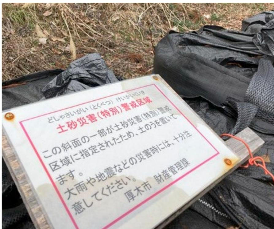
4. 土砂防用トン袋の列（斜面とトン袋の間で土砂をとどめる計画）
